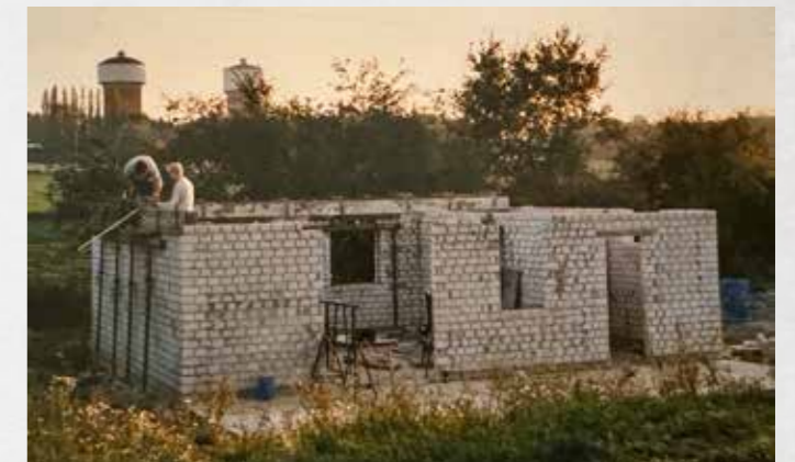
Die Laube im Rohbau im Schatten der Wassertürme
